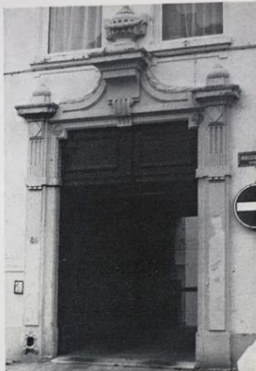
104. Keizerstraat nr. 64. Poortomlijsting.
