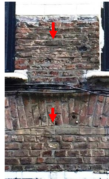
Fig. 3. huis Olifant, Lange Nieuwstraat 154, mogelijke plaatsen van de huisnaamplaat.
